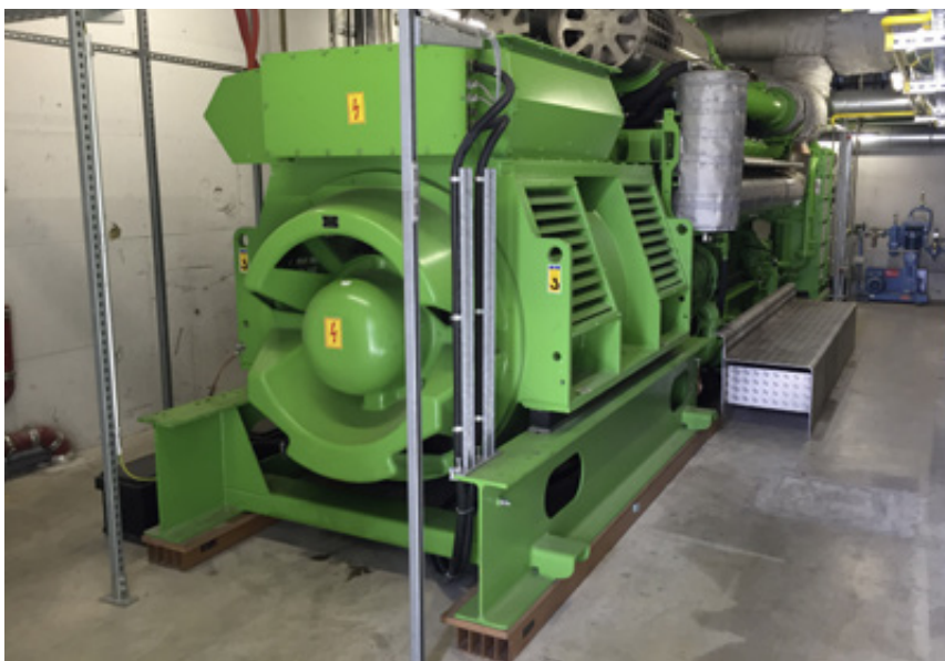
Abb. 4: Das im Praxisbeispiel genannte BHKW (Leistung: 1,2 MW e ) erreicht Mehrerlöse von 10 Euro/MWh
